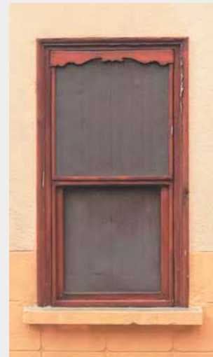
Maury - Fenêtre équipée d'une moustiquaire devant des contrevents à brisures verticales
