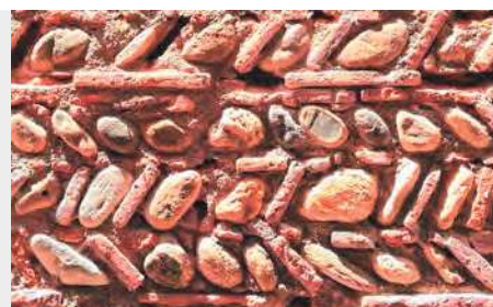
Mur mixte de galets avec inclusion et assise en cayrou
