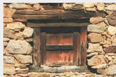
Fenestrou - linteau et encadrement en bois
