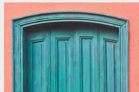
Chambranle en bois à fascies sur linteau en arc surbaissé
