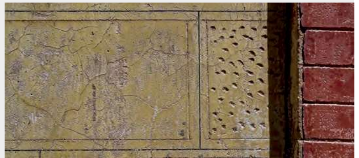
Enduit imitation en pierre de taille avec effet de deux textures
