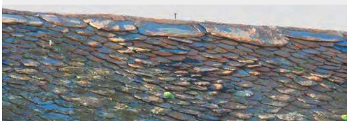
Faitage d'une toiture en llose
