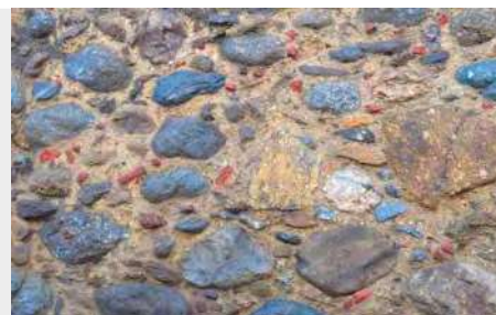
Moellon* de pierres de diverses natures avec quelques inclusions de cayrou
