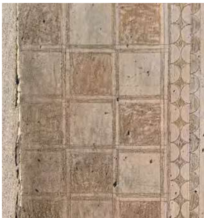
Chaîne d'angle en enduit sgraffite
