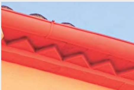
Corniche de briques agencées et/ou moulurées
