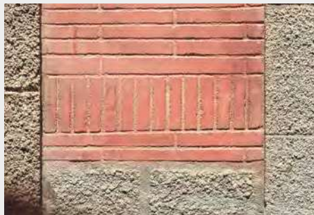
Deux exemples d'enduit sculpté imitation brique
