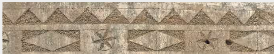
Bandeau en enduit sgraffite
