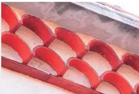
Génoise à plusieurs rangées de tuiles
