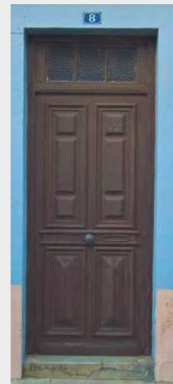
Bages - Porte début 20 e à imposte vitrée et à motif renaissance autour de la serrurerie - Panneaux en pointe de diamant en partie inférieure
