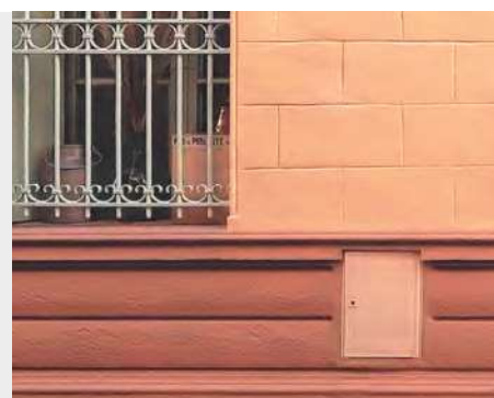
Soubassement en enduit épais sculpté
