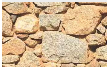
Moellon* de pierre de granite de Railleu
