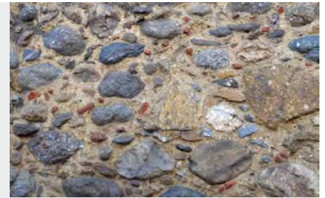
Moellon* de pierres de diverses natures avec quelques inclusions de cayrou
