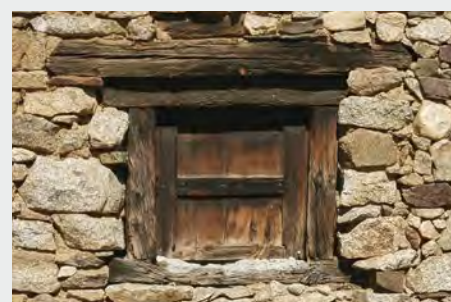
Fenestrou - linteau et encadrement en bois
