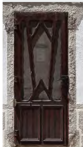
Laroque-des-Albères Porte vitrée équipée d'une moustiquaires ouvragée
