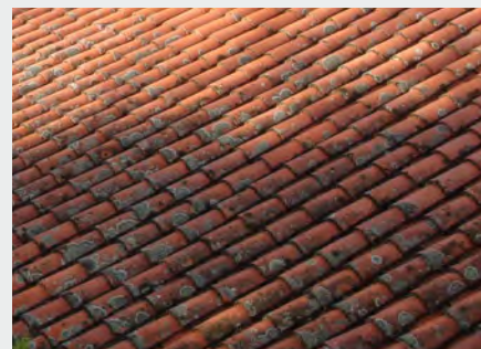
Toiture en tuile canal
