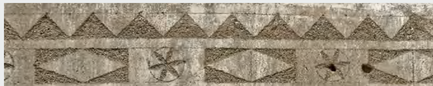
Bandeau en enduit sgraffite
